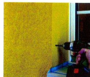
Avvitare l'oggetto da montare nella MTH ELEMENTO DI FISSAGGIO INTERNO SPALLETTA Tra-Wik-PH
