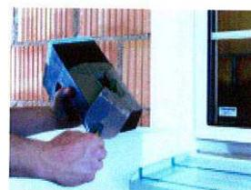
Premere MTH ELEMENTO DI FISSAGGIO INTERNO SPALLETTA Tra-Wik-PH a filo dei pannelli isolanti, nella sezione fresata.
